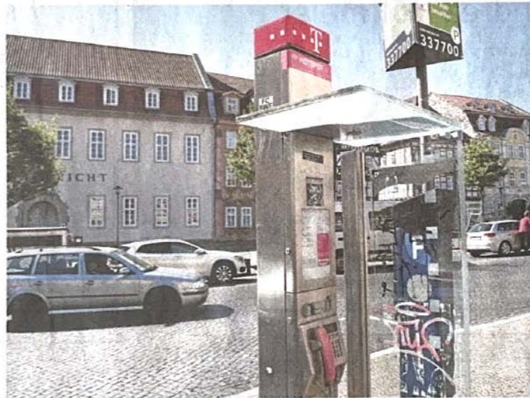
Der Hotspot der Telekom am Untermarkt in Mühlhausen ist einer der letzten im Stadtgebiet und momentan außer Betrieb.
