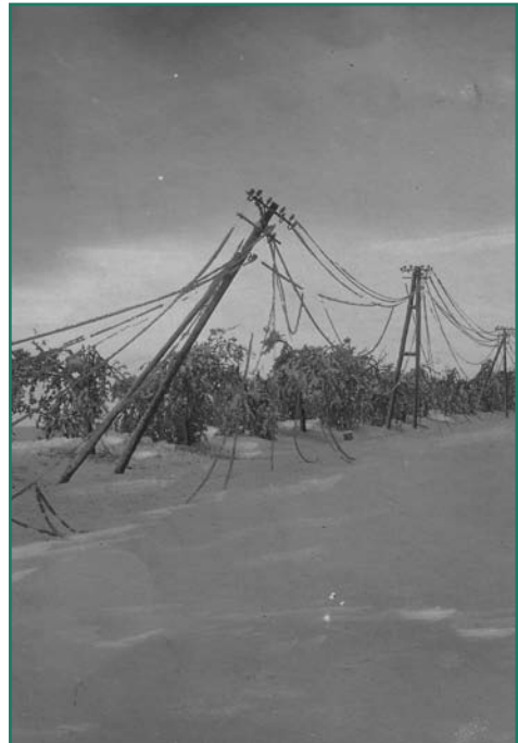
Raureif- und Sturmschden an der Fernlinie MHL-Windeberg/Keula Foto: J. Richter
