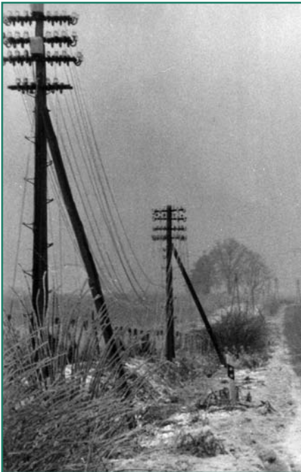
Raureif- und Sturmschden an der Fernlinie MHL-Windeberg/Keula Foto: J. Richter
