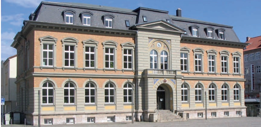
Generalpostdirektor Heinrich Stephan ließ dieses Gebäude 1880-1882 als Kaiserliches Post- und Telegrafenamtsgebäude erbauen. Am 01. Juni 1887 wurde im 1. Obergeschoss die erste Stadtfernsprechanlage für die Stadt Mühlhausen als Handvermittlung für 27 Fernsprechanlüsse eingerichtet. Foto: Gerhard Fiedler, 2003
