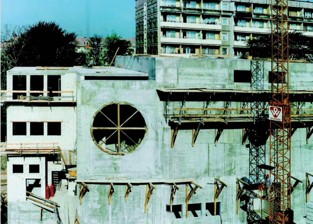
Fertigstellung der Betonierungsarbeiten am Obergeschoss des Technikgebäudes. Fotos: Peter Schrön, 1991
