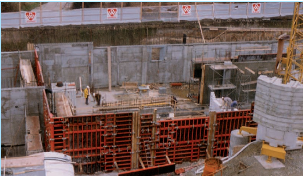
1991 Einschalung und Betonierung des Tiefgeschosses für das Technikgebäude.
