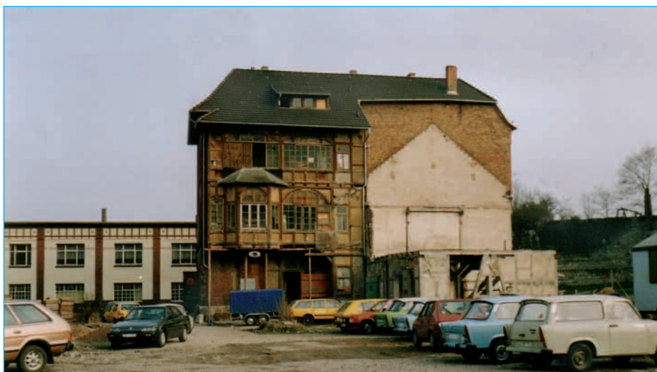
Das Wohn- und Geschäftshaus der Burgmühle während der Abrißphase. Fotos: Gerhard Fiedler, 1991
